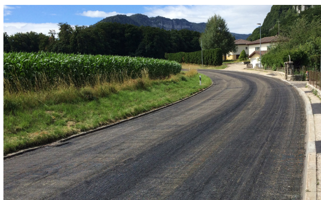
Exempel på ett S&P asfaltarmeringsnät installerat i en kurva
