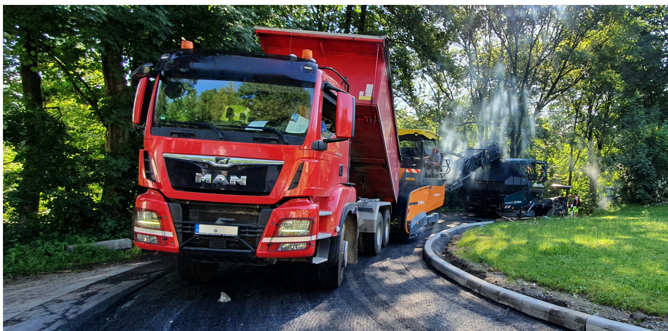
Asfaltläggare och transportfordon måste köras försiktigt
