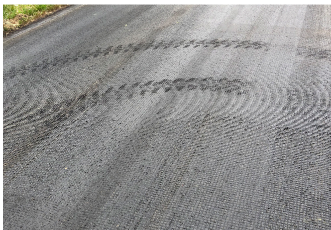
Däckspår synliga på ovansidan av nätet
