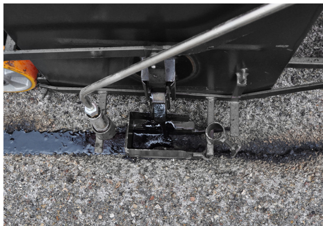
Sprickfyllning med varm bitumen
