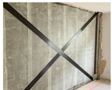
Stabilitetsförstärkning med S&P G-Sheet och S&P C-laminat
