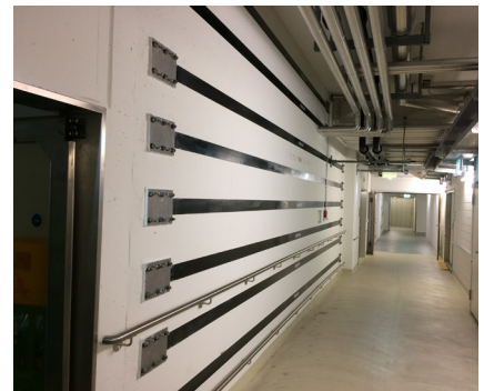
Skjuvförstärkning med förspänt S&P C-laminat
