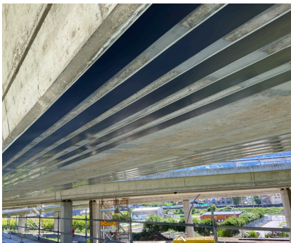
Momentförstärkning med externt pålimmat S&P C-laminat
