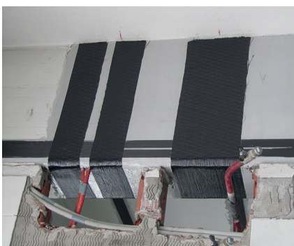
Skjuvförstärkning med S&P C-Sheet 640
