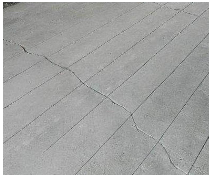
Momentförstärkning med Near Surface Mounted (NSM) S&P C-Laminat eller C-Rod
