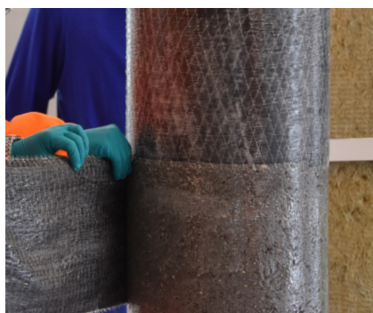
Pelarförstärkning med S&P C-Sheet 240
