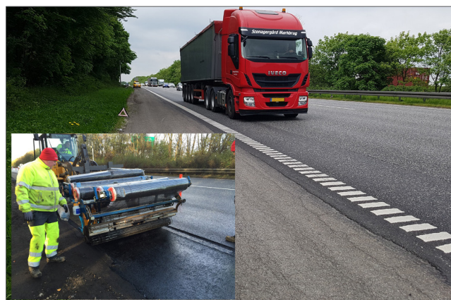
▲ Bild 4: M40 - Utläggning av förstärkningsnät under slitlager
