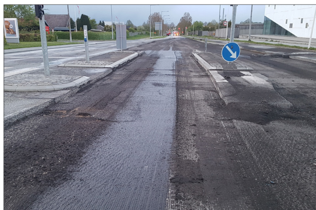
▲ Bild 5: Vejlevej - Vestre Ringvej, Fräsning innan utläggning av förstärkningsnät
