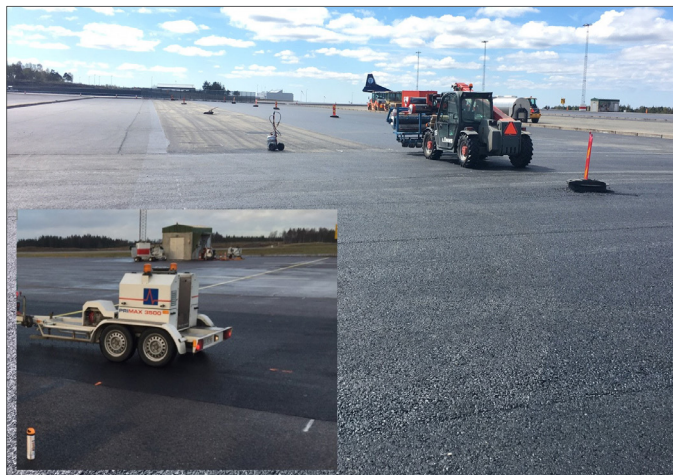
▲ Bild 1: Göteborgs flygplats, fallloggning och kolfiberförstärkning av parkeringsplatser för flygplan
