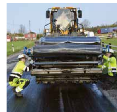
5 Fäst upp nätrullen på maskinen. Sidan med plast ska vara ner mot asfalten och den sandade sidan uppåt.
