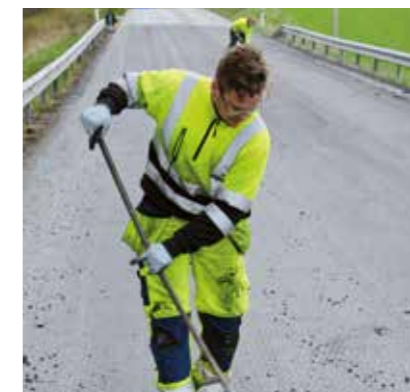
2 Rengör ytan där nätet ska ligga så ytan är torr och fri från smuts.
