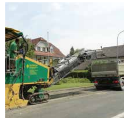
1 Fräsning / förberedning av ytan.
