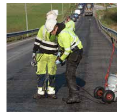
8 Överlappet ska vara ca 30-50 cm när man skarvar med ny rulle. När nätet läggs i bredd ska överlappet vara 10-20 cm.
