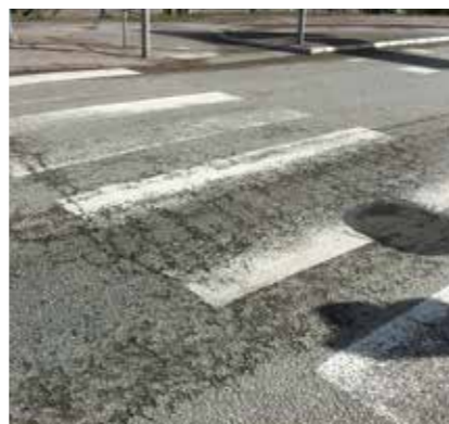
Det aktuella området krävde ständiga omläggningar av asfalten.
