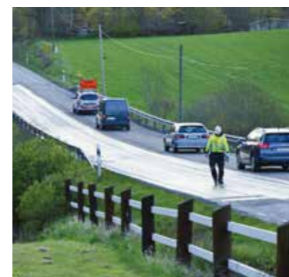
4 Låt emulsionen fälla ut ordentligt innan läggning av nät påbörjas.
