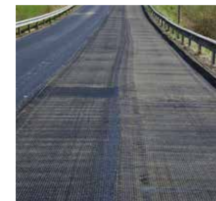
9 Nätet är klart att läggas över med asfalt.
