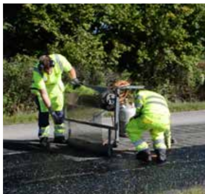
1 Fäst upp nätrullen på maskinen.
