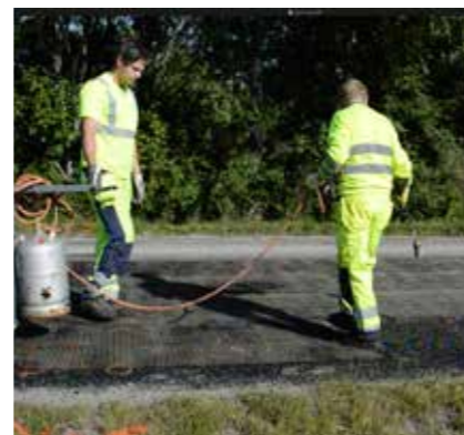
3 Bränn skarvarna försiktigt och trampa ihop näten med små steg när rullbyte sker.
