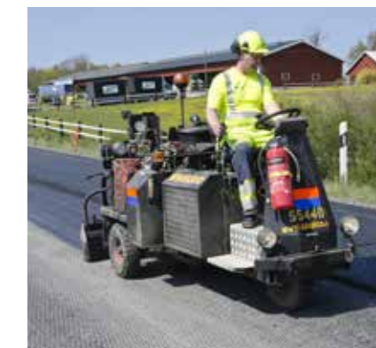
3 Klistra ytan med bitumenemulsion.
