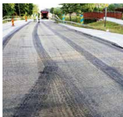
Konstruktionen på S&P:s förstärkningsnät gör att det lätt kan läggas i kurvor.
