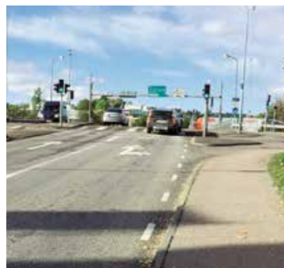
Området 5 år efter förstärkning. Inga sprickor och ingen tydlig spårbildning.
